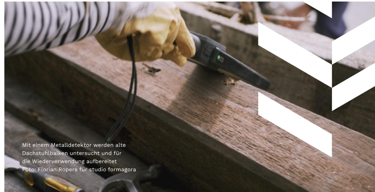
Mit einem Metalldetektor werden alte Dachstuhlbalke untersucht und für die Wiederverwendung aufbereitet
